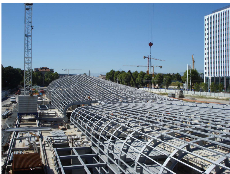
Copertura di Porta Susa
